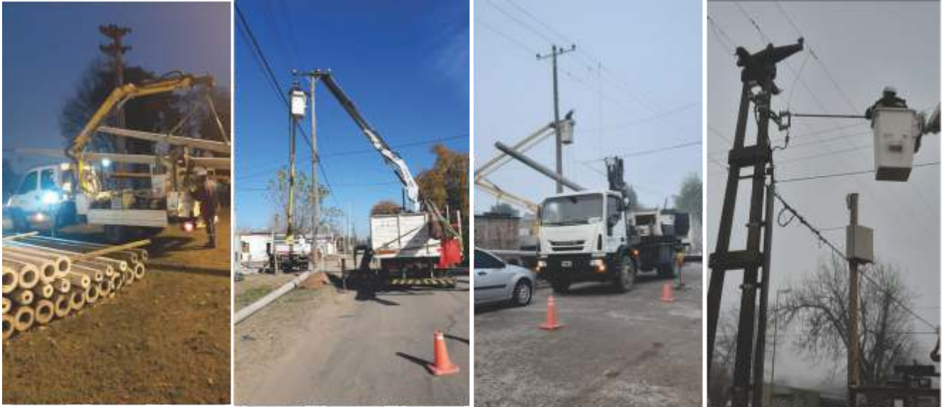
Cambio postación en alimentador Sudamtex, por calle Las Flores hasta el Frigorífico
